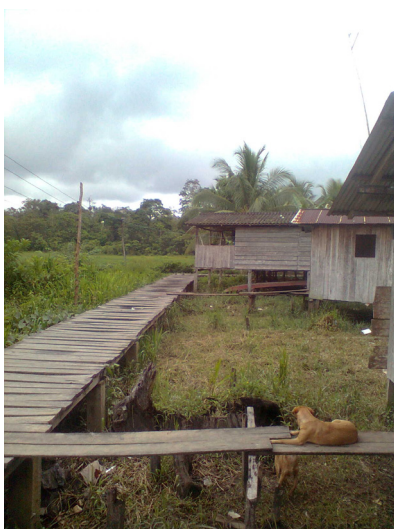
Imagen 1. Puente-calle construido durante la administración vigente para ingresar al barrio San Francisco porque cuando crece el río Saija se inundan todas las zonas riverseñas. 5
