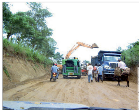
Construcción de la Troncal de los Montes de María. Tramo El Carmen de Bolívar – Caracolí. Noviembre de 2008.
