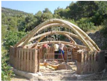
Ilustración 7. cubiertas. taller de construcción con cañas. Martha Denigri
